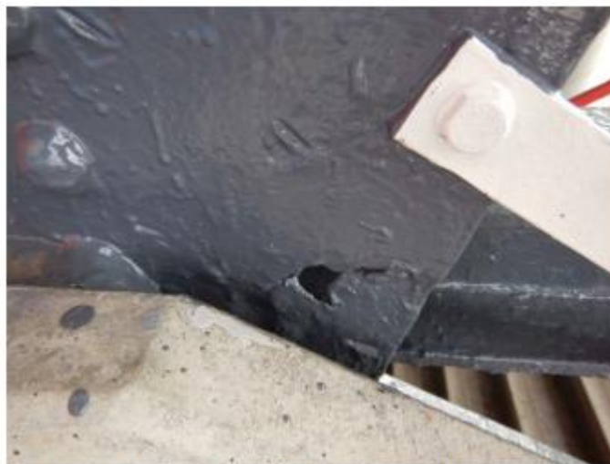
Afbeelding 5.2-3: Gat in de schetsplaat (detail)
