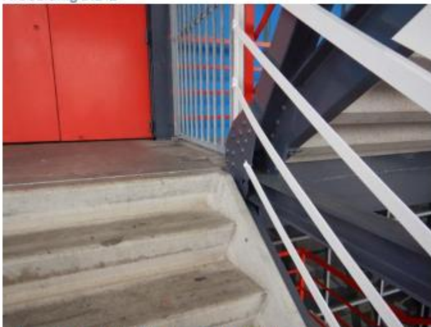
Afbeelding 5.2-2 Gat in de schetsplaat (overzicht)
