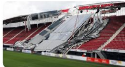
Instorting dak AZ stadion. Met keuringen zijn instortingen te voorkomen. (Bron: Onderzoeksraad voor Veiligheid)
